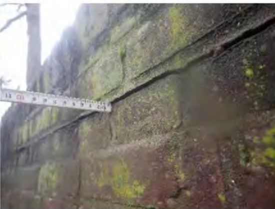
Foto 05: Loskomende rollaag
