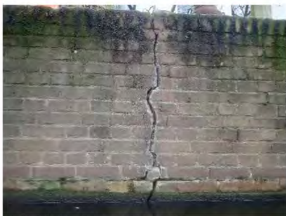
Foto 13: Verticale scheur H17
