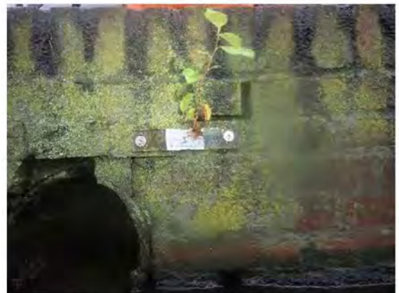
Foto 04: Scheurverklikker bij doorvoer
