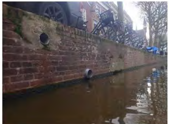
Foto 04: Los metselwerk rondom doorvoeren
