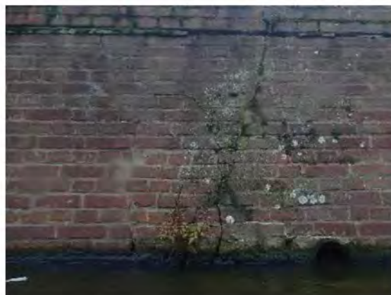
Foto 08: Verticale scheur
