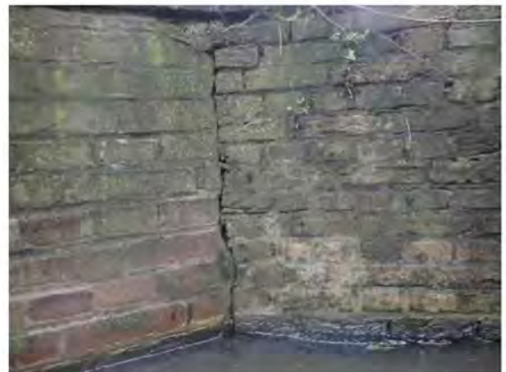
Foto 04: Aansluiting op walmuur 1006-2
