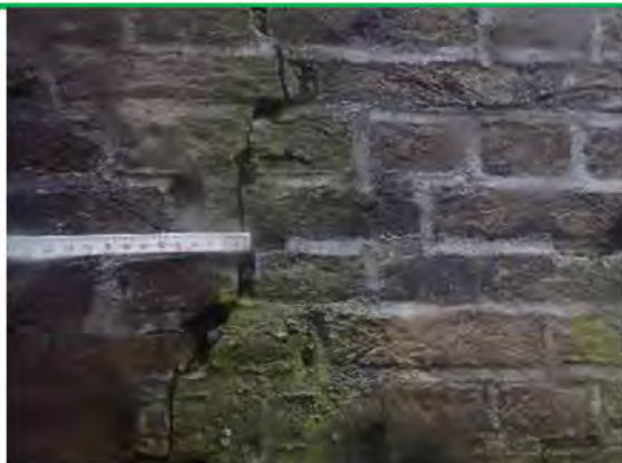
Foto 05: Verticale scheur op ca 7 m
