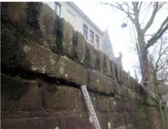
Foto 03: Rollaag komt los
