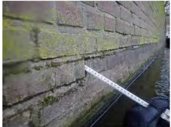
Foto 02: Horizontale scheur over lintvoeg
