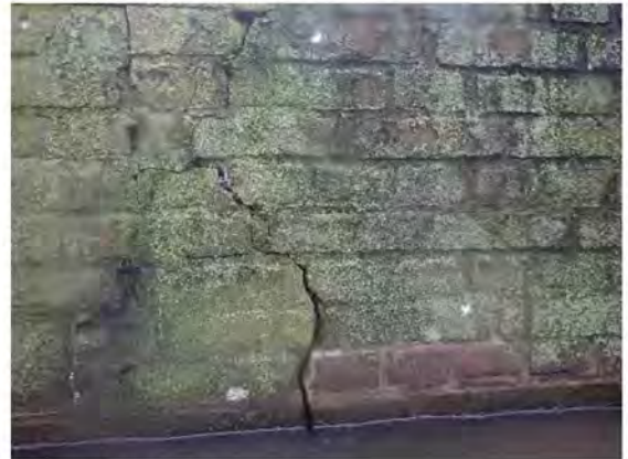
Foto 02: Verticale scheur
