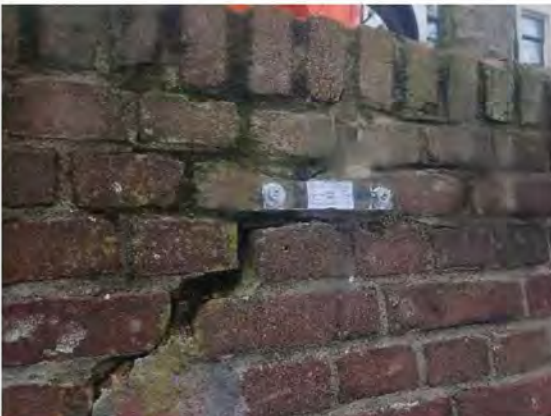
Foto 03: Schuin verlopende scheur
