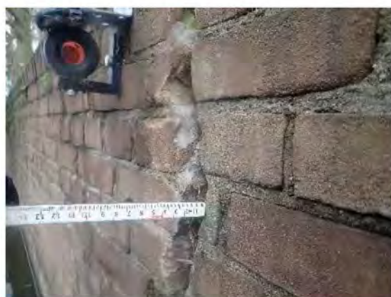
Foto 16: Scheur H19 en zettingsverschil
