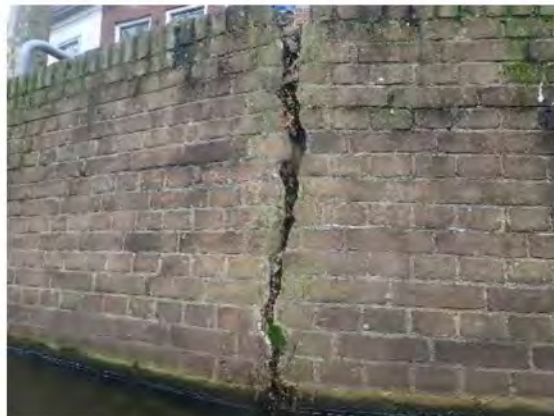
Foto 02: Verticale scheur
