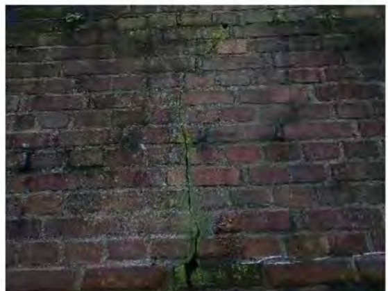
Foto 04: Verticale scheur
