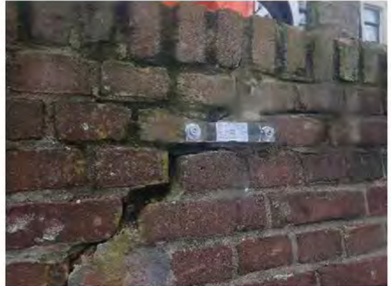
Foto 02: Schuin verlopende scheur
