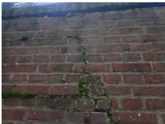
Foto 07: Verticale scheur
