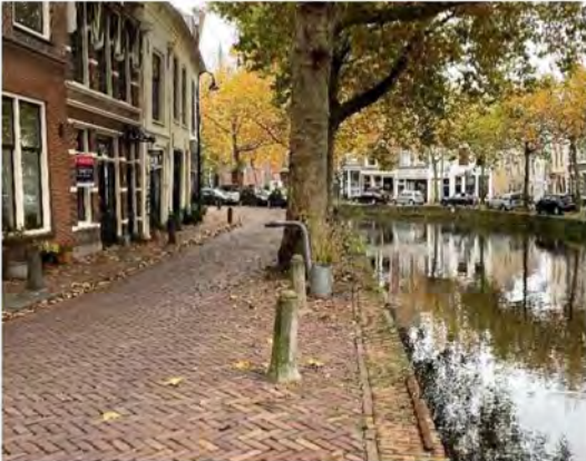
Foto 01: Walmuur aan de Amsterdamsche Verlaat
