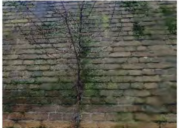
Foto 02: Klein zettingsverschil bij dilatatievoeg
