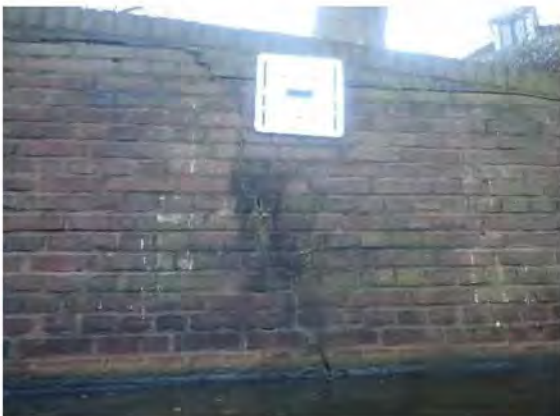
Foto 03: Verticale scheur
