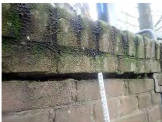
Foto 15: Losliggende rollaag
