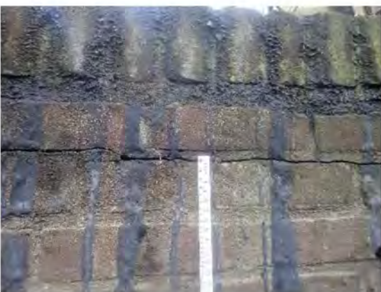
Foto 05: Horizontale scheur onder rollaag
