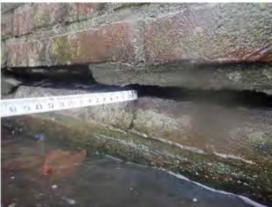
Foto 03: Horizontale scheur
