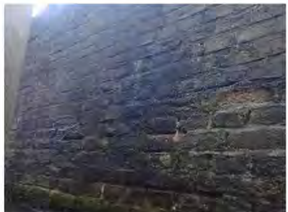
Foto 04: Kleine scheuren en vochtuittreiding
