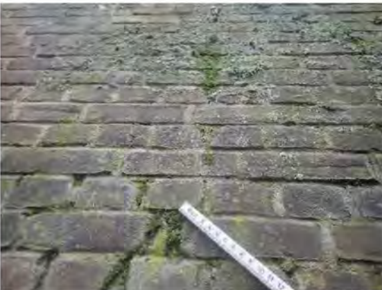
Foto 03: Kleine verticale scheuren
