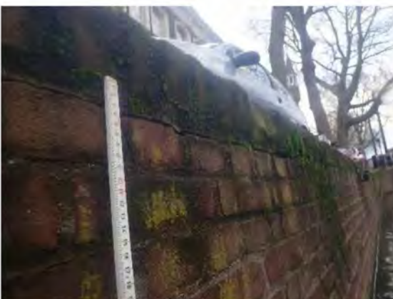
Foto 05: Loskomende rollaag
