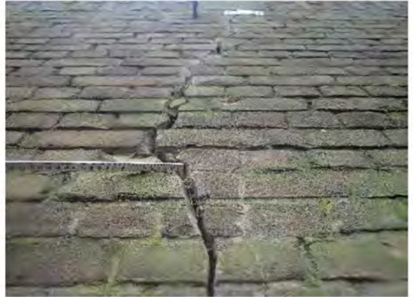
Foto 04: Detail scheur (foto 03)
