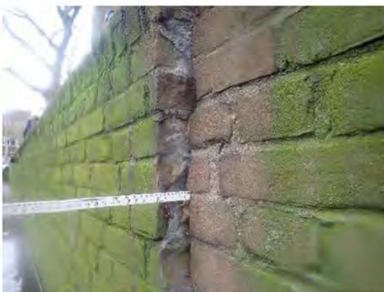
Foto 09: Ongelijkmatige zetting bij scheur I11
