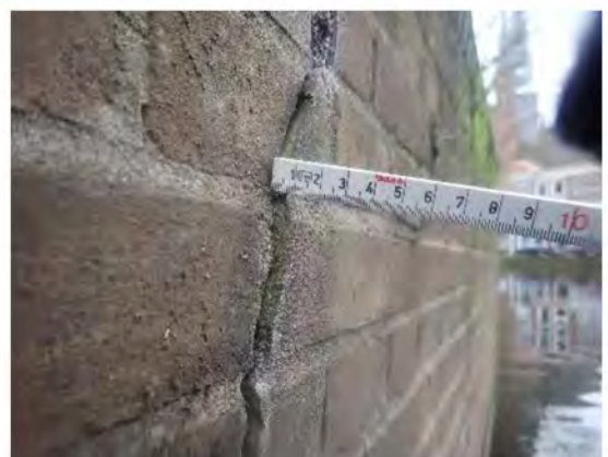
Foto 12: Zettingsverschil scheur H16
