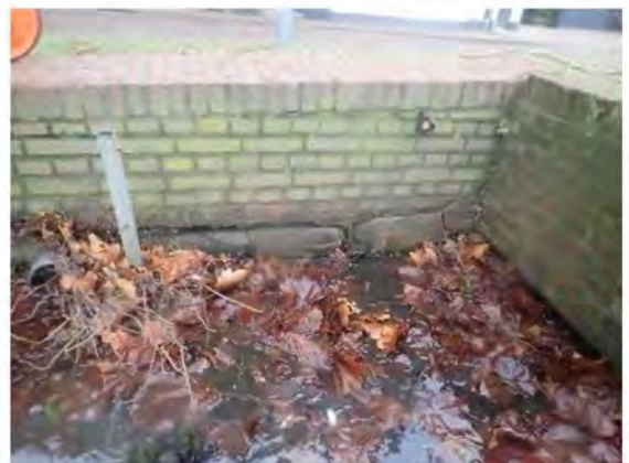
Foto 6: Gedesintegreerd metselwerk
