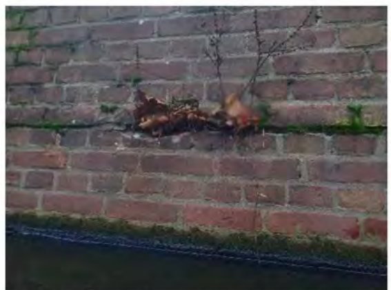
Foto 06: Horizontale scheur en begroeiing
