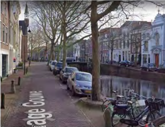
Foto 01: Parkeren en bomen op de walmuur
