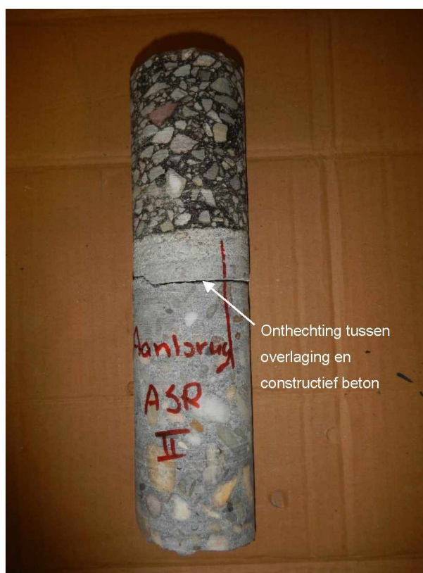
Figuur 32: Aanbrug ASR kern II
